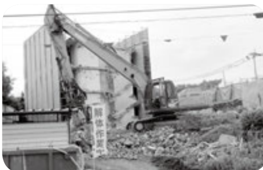
工事中は危険がいっぱい
