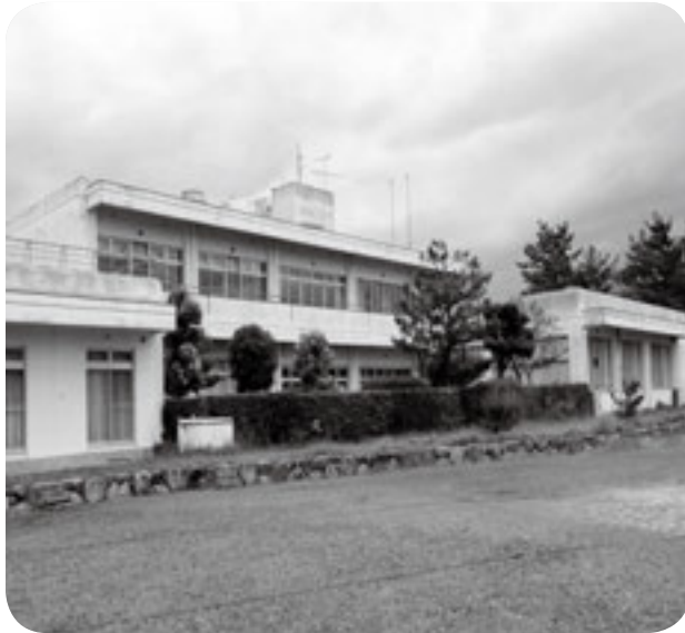
劣化・老朽化が進んでいる健康福祉センター
