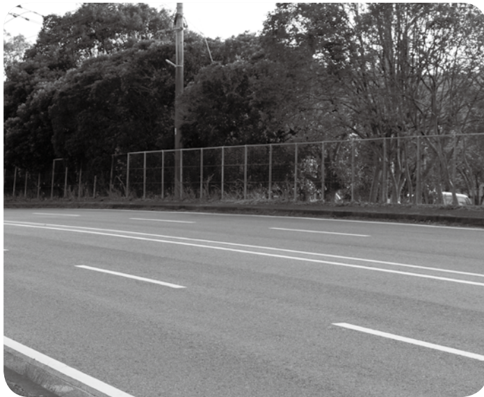
水道管漏水、住民への影響は
