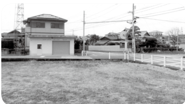
第6分団消防格納庫付近
