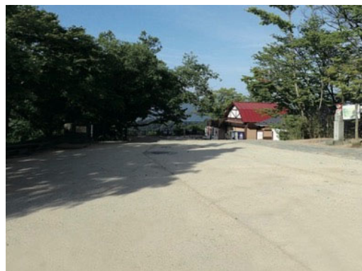
土系舗装の施工事例（カタログより）
