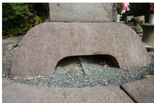
礎石が水平になっていない
