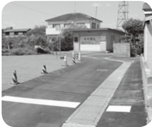
消防団出動不便解消の工事完了！
