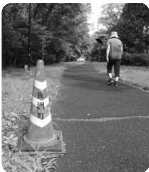
補修された遊歩道
