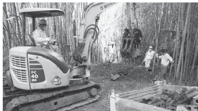
重機も使って撤去作業をしました
