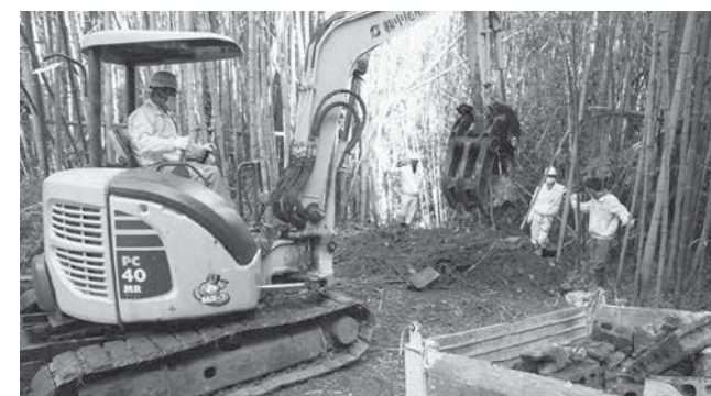
重機も使って撤去作業をしました
