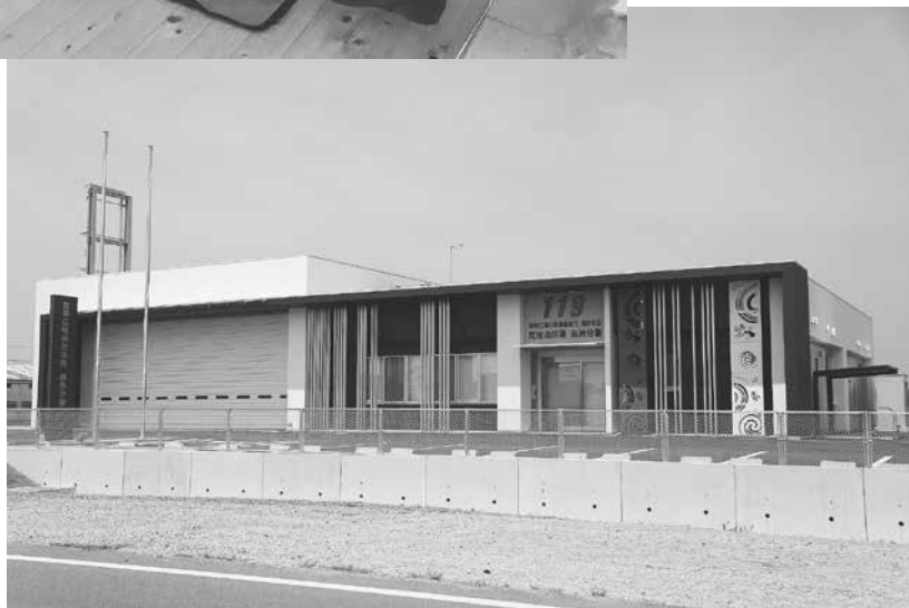
令和3年7月1日 共用開設された荒尾消防署長洲分署庁舎
