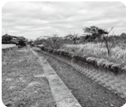
上沖洲整理川(水路)に堆積した土砂の浚渫(しゅんせつ)を求める
