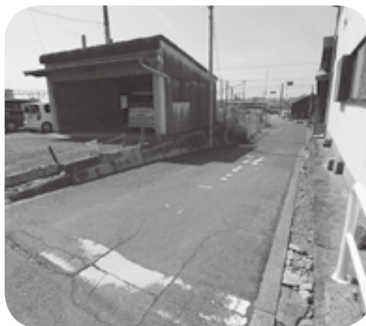
踏切道の前後も危険（堀崎踏切）
