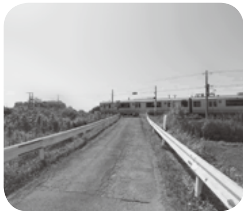
改良すべき踏切道（折地踏切）
