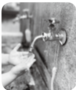
水道管の劣化が進んでいる
