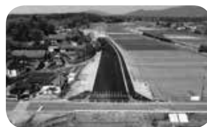
町道赤田・上沖洲線 (土木費)
