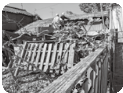
解体が進む空き家
