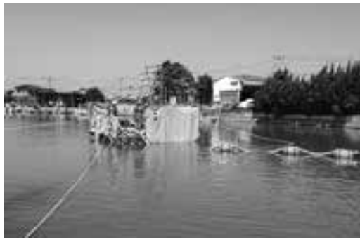
港内での浚渫作業
