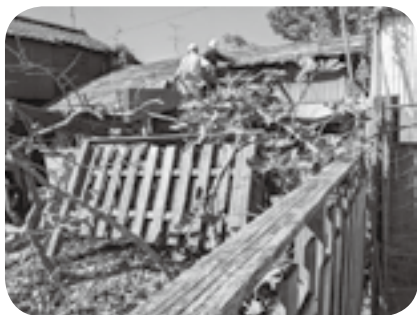
解体が進む空き家
