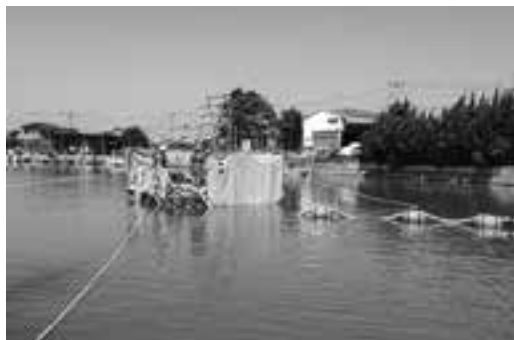
港内での浚渫作業
