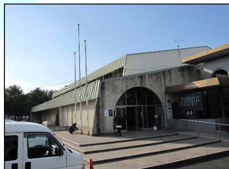
長洲町総合スポーツセンター
