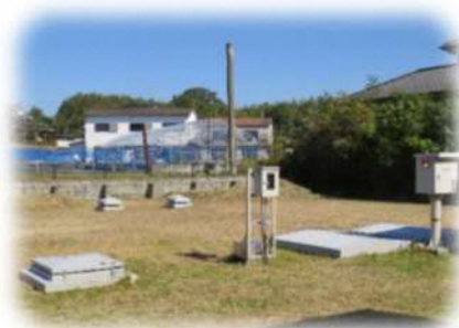
梅田浄水場内（地下RC配水池）
