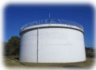
高田浄水場内（PC配水池）
