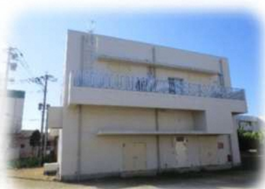
腹赤浄水場内（管理棟）
