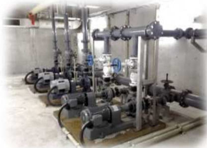
梅田浄水場内（加圧ポンプ設備）
