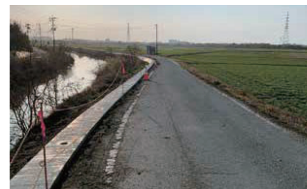
3 【宮崎川沿い道路】 道路拡張、転落防止柵設置、防犯灯設置
