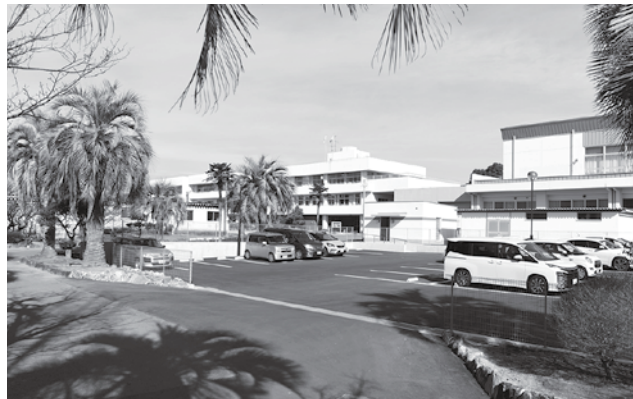
屋外プールを解体し、新たに駐車場として整備しました。
