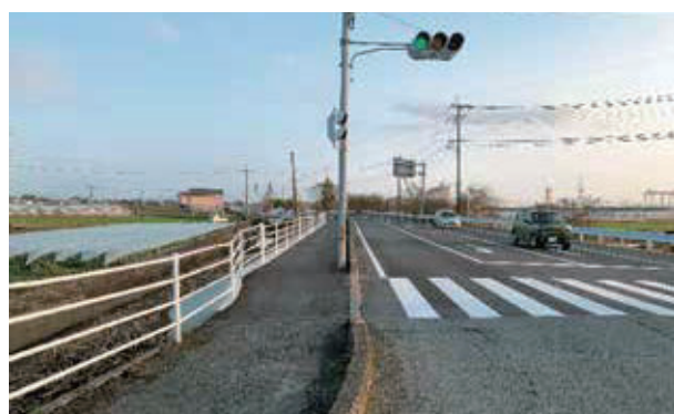
9 【県道長洲玉名線（高浜団地～月華苑付近）】 歩道舗装、転落防止柵修繕、防草対策
