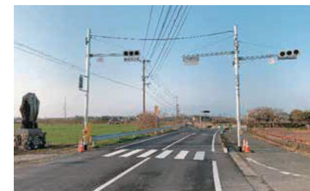
4 【県道長洲玉名線（月華苑付近）】 押しボタン式信号設置
