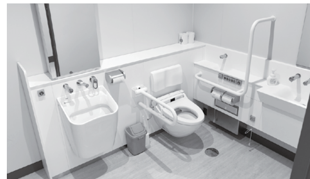
西棟1階トイレは車椅子等でも利用できるよう多目的トイレへ改修しました。
