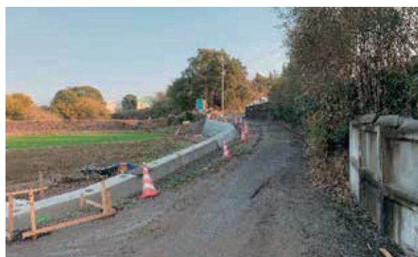
11 【下北口・大木浦線（中学校西側）】 道路拡幅、転落防止柵設置、防犯灯設置
