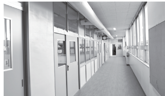
廊下の照明をLED化し、東棟の廊下は床材を変更しました。
