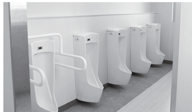
校舎内のトイレは便器等含め全面的に改修しました。
