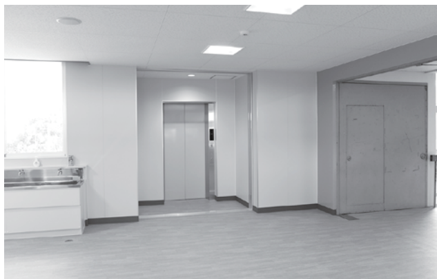
東棟にエレベーターを新たに整備しました。
