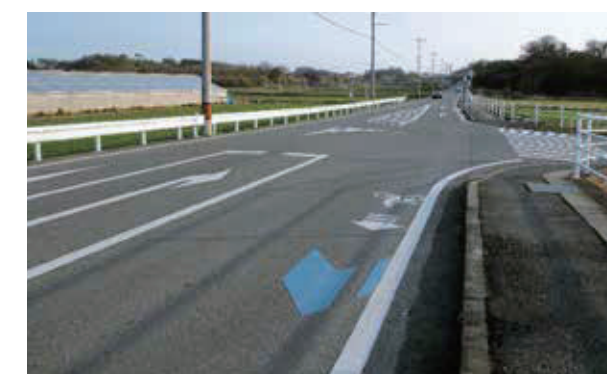
2 【上沖洲・鷺巣線（向野踏切～中学校）】 自転車通行表示、LED灯への取替
