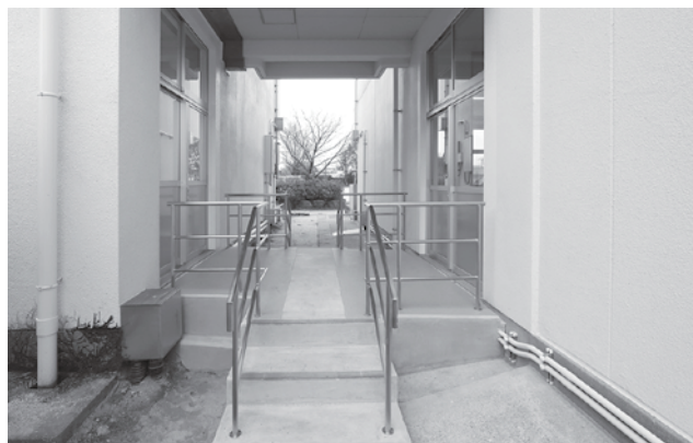
1階の渡り廊下（東棟と西棟の間）を安全に行き来できるよう整備しました。
