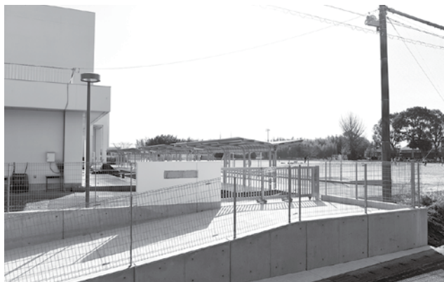
校舎西側に新たな生徒通用口として、西門を整備しました。
