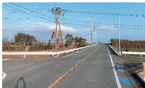
6 【長洲・岱明線（長洲町役場～宮崎川）】 自転車通行表示、防草対策、沿線の伐採除草、 防犯灯設置
