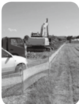
工事は着々と進行中
