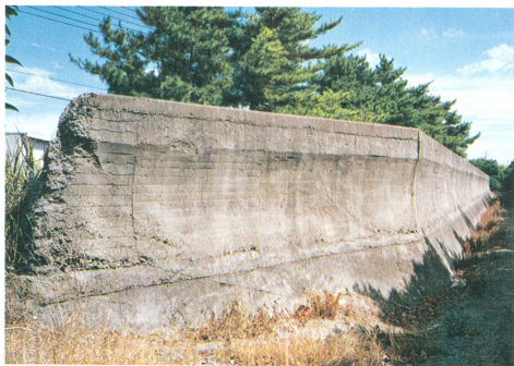
姫ヶ浦防潮堤と防風林
